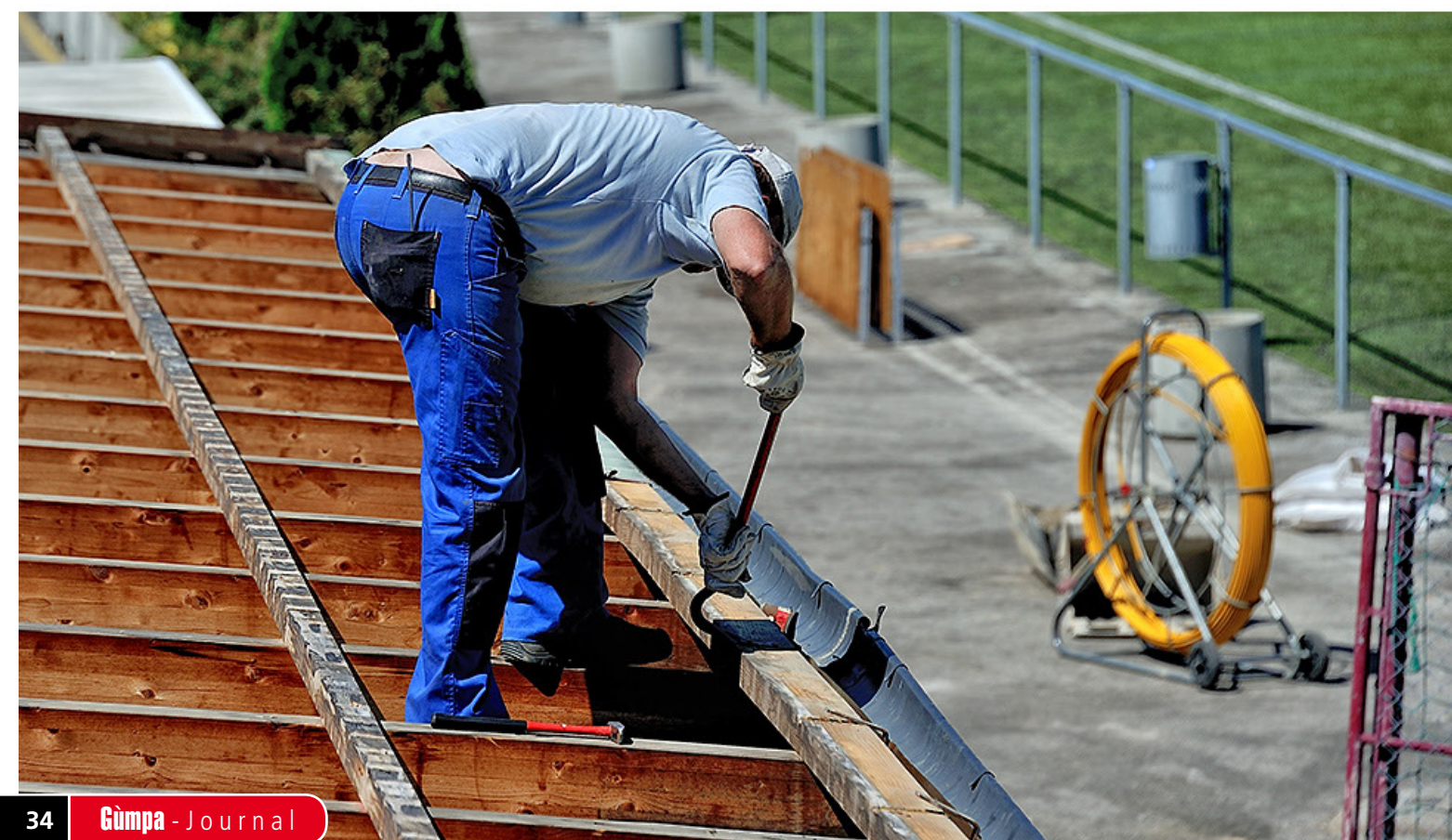
Das Kabel für TV und Internet wird eingezogen
